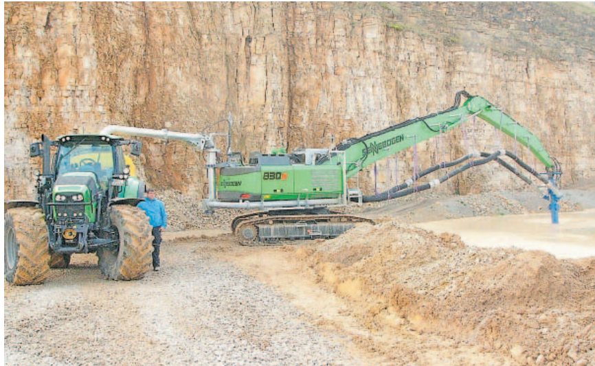
Das Dolomin, eine Kalk-Ton-Suspension, wird aus dem Teich gepumpt und zeitgleich in das Güllefass umgefüllt. Foto: Jutta Riedel
