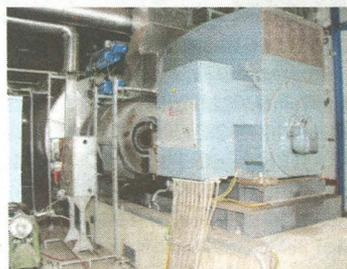
Die zwei großen Biomasseheizkessel im Erdenwerk Ziegler sind mit einer ORC-Turbine (unten) zur Stromerzeugung gekoppelt.
